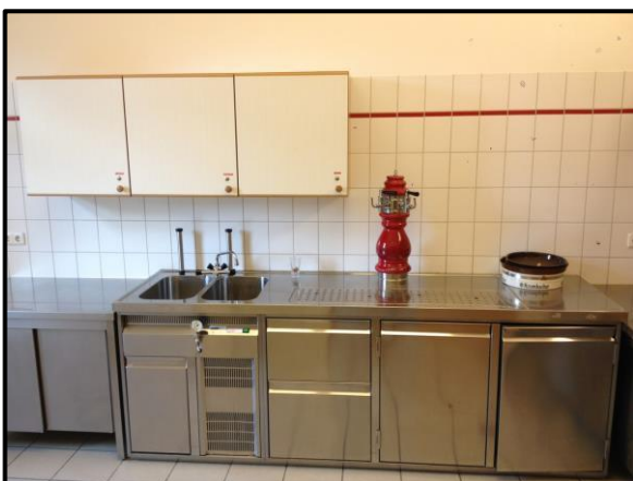
Voll ausgestattete Großküche
